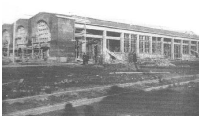
Строительство главного корпуса АМО, 1916 г. Фото из книги Л.Шугурова, 2004.
