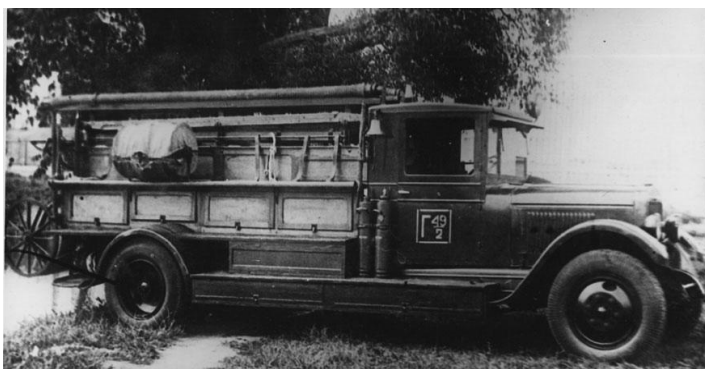
Пожарный автонасос-линейка ПМЗ-1 на шасси ЗИС-11 http://fire-truck.ru/encyclopedia/pozharnviv-avtonasos-pmz-1-1934-god.html
