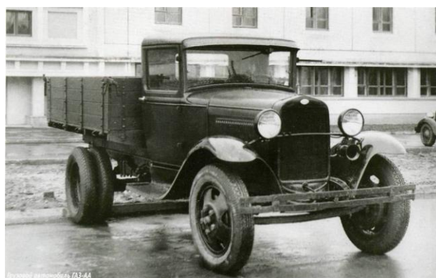
Серийный «Ford AA» московского завода им. КИМ с задними двускатными колесами и отечественной бортовой грузовой платформой, 1931 г. Фото из книги Е.Д. Кочнева, 2009.
